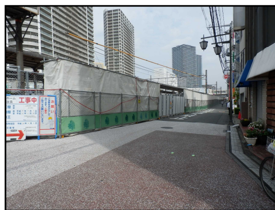
新西口改札付近の仮囲い（下り線）
