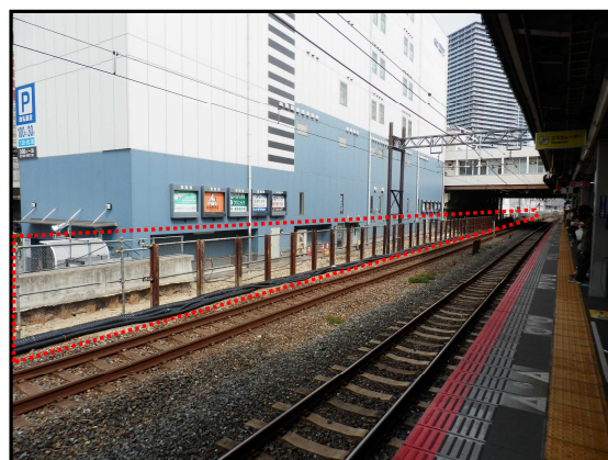
既存線路の防護（上り線）
