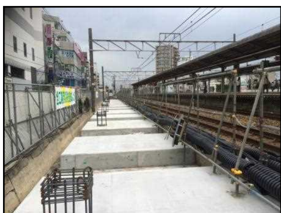
ホーム基礎工事（下り線）
