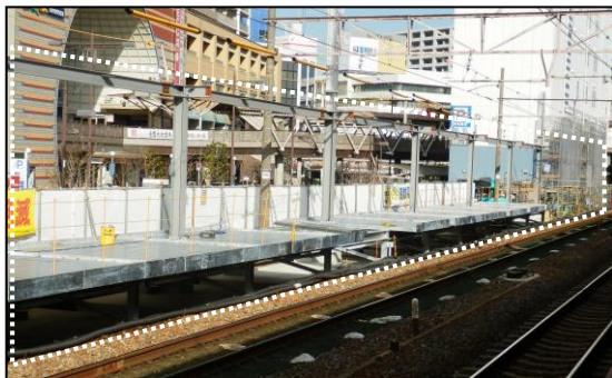
ホーム新設工事（上り線）
