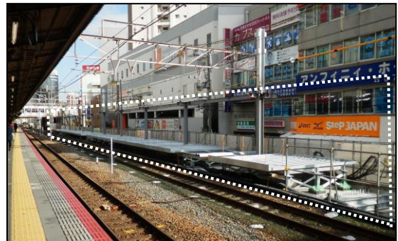
ホーム新設工事（下り線）
