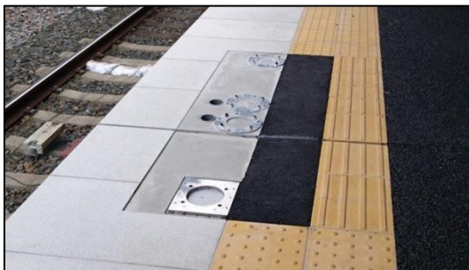
基礎部 施工状況
