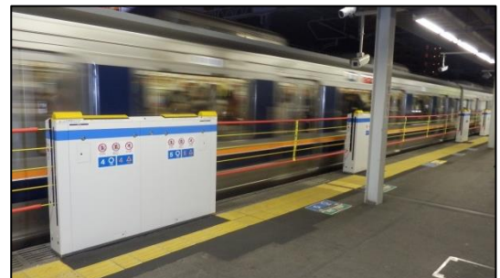
昇降式ホーム柵（六甲道駅での試行状況）
