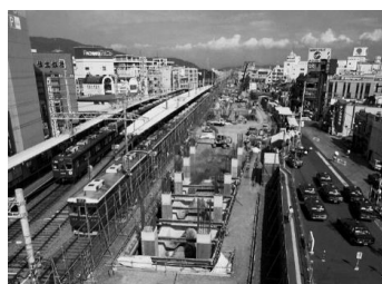
阪急京都線連続立体交差事業
