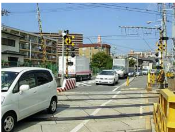
富田西踏切の現況写真
