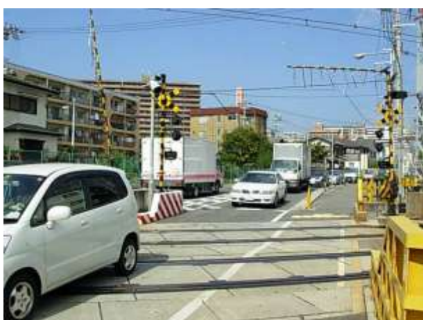
富田西踏切の現況写真
