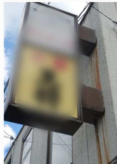
内部の腐食が懸念される事例
