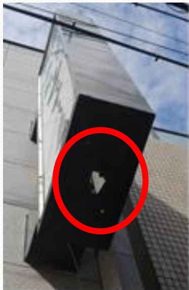
破損が見られる事例
