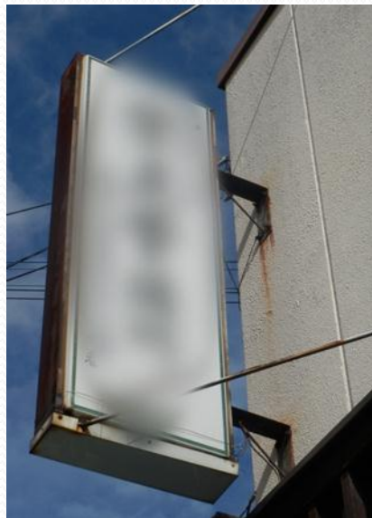
老朽化している事例
