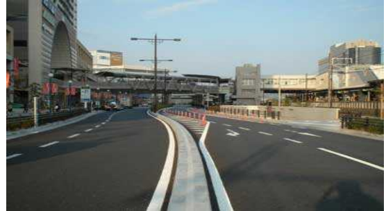
無電柱化された高槻北駅南芥川線
