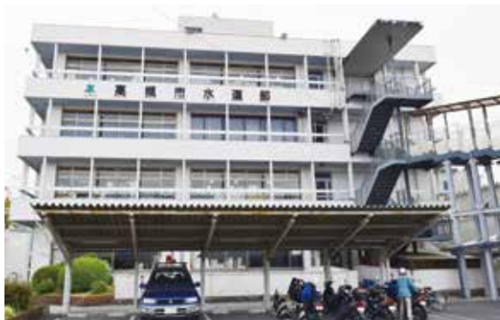
▶建て替え後の跡地の利活用が検討されている水道庁舎
