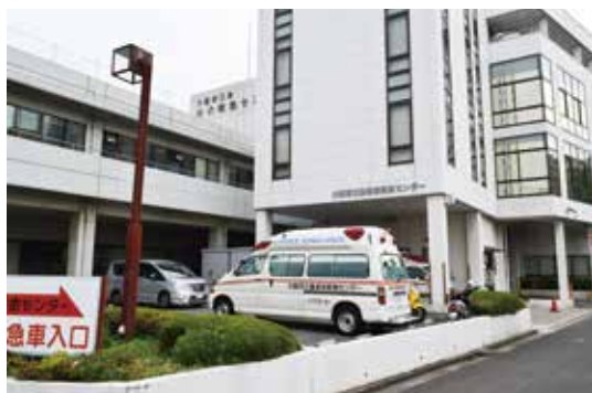
▲耐震等のため、建て替えの検討が進む三島救命救急センター
