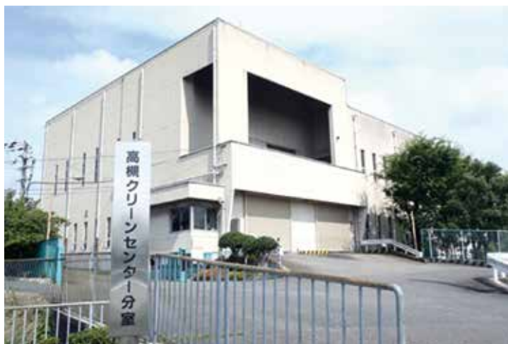
▲本市のし尿処理を担っている高槻クリーンセンター分室
